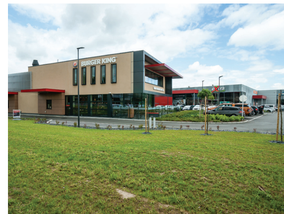
Site 53 - Auvelais - Espace 58 - Rue de l'Essor 1 - 10,767 m 2 bâtis - Commerces
