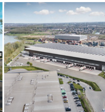
Garocentre - Q1 2026 - Heylen Warehouses - 30.000 m 2
