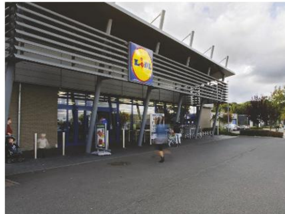
Site 13 - Centre commercial City Nord à Gosselies - 30.548 m 2 - Commerces
